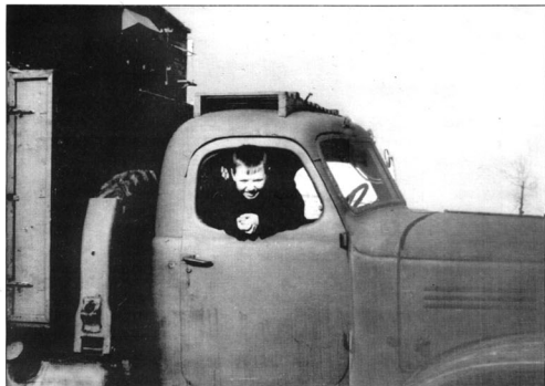
Кабина ЗиЛ-151 с КУНГ радиолокационной станции ПВО. Фото 1959 г.
