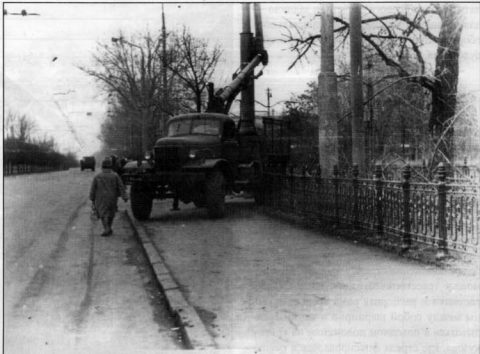
Подъемная вышка МШТ-2А (?) на шасси ЗиЛ-157К. Снимок сделан в Харькове в конце 1960-х.
